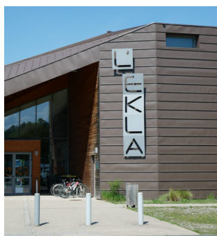
Médiathèque / Salle de Spectacle
