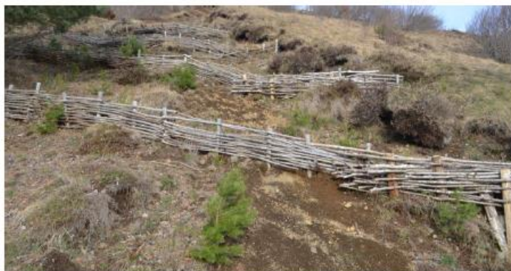
Exemples de seuils pour effacement doux d'une ravine
