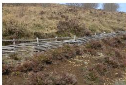
Exemples de seuils en fascines, emmarchements, renvois d'eau sur chemins piétons
