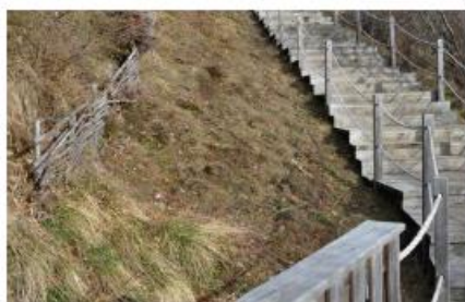
Exemples de seuils en fascines, emmarchements, renvois d'eau sur chemins piétons
