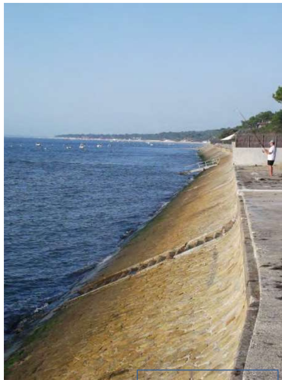
Perré à la Corniche, Pyla-sur-Mer
