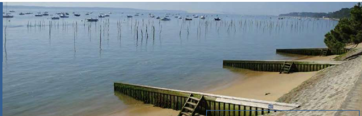
Perrés, épis et pignots le long de la presqu'île du Cap Ferret
