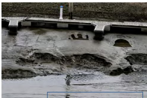
Envasement dans le port d'Andernos
