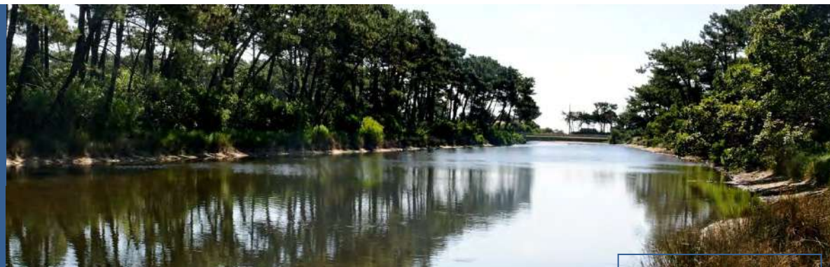
Site des réservoirs de Pirailan
