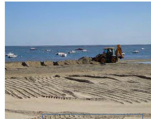
Travaux de rechargement en sable des plages
